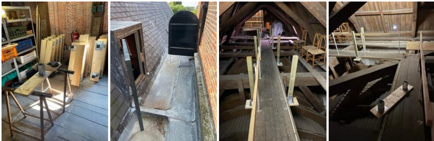
Werkplaats op de toren zolder, entree (door de dakgoot) naar kerkzolder, nieuwe balustrades in aanleg.
